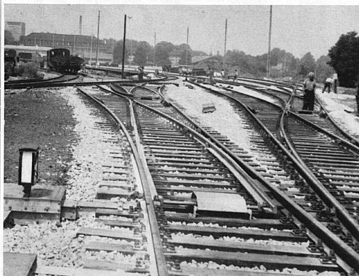
Ausbau Basel GB
