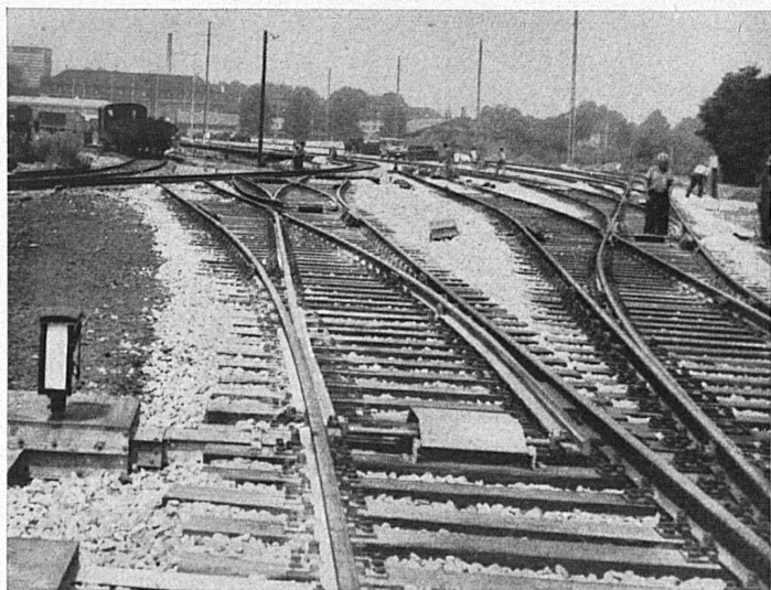
Ausbau Basel GB
