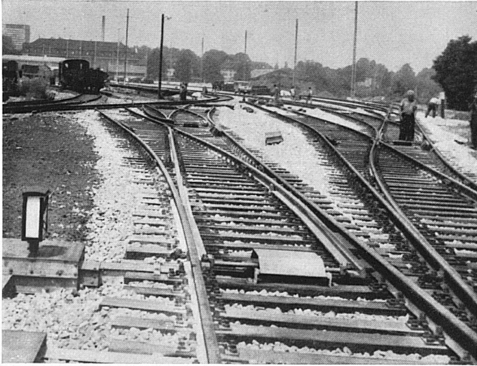
Ausbau Basel GB
