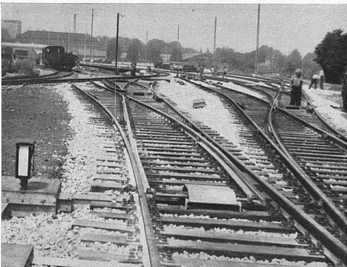
Ausbau Basel GB
