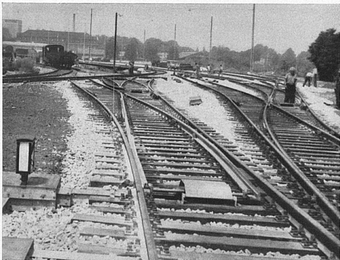
Ausbau Basel GB
