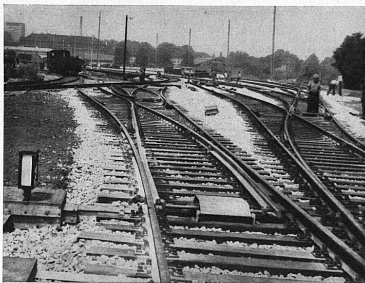
Ausbau Basel GB
