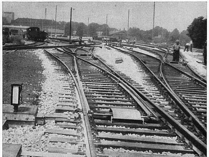
Ausbau Basel GB
