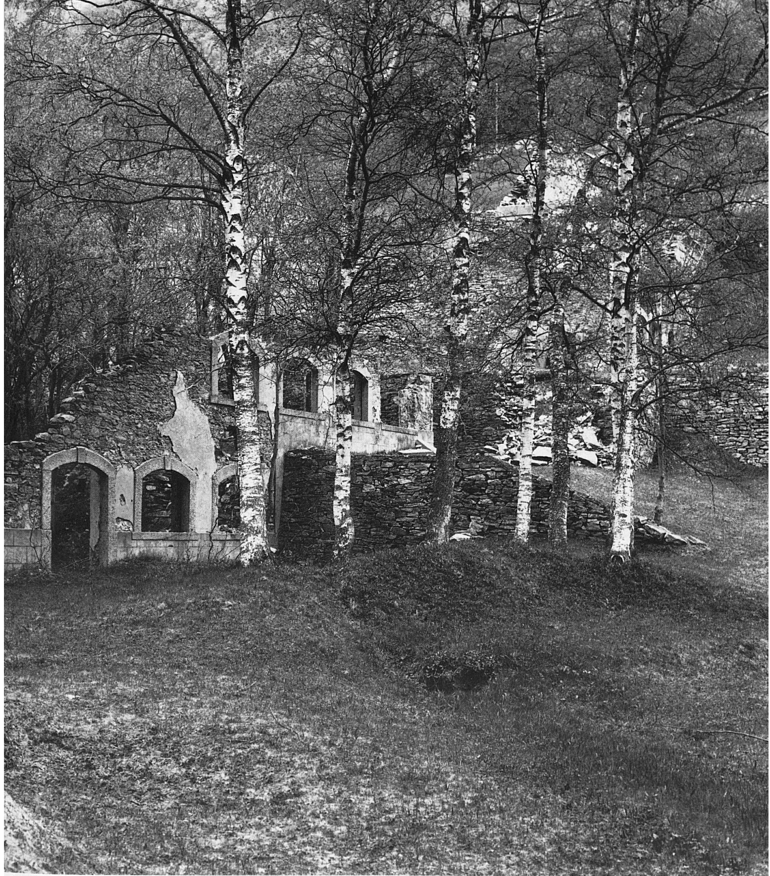
Le miniere d'oro di suo tempo si trovano ad un'ora al di sopra del paese frontaliere di Gondo presso la piccola strada nella vallata Zwischbergen
