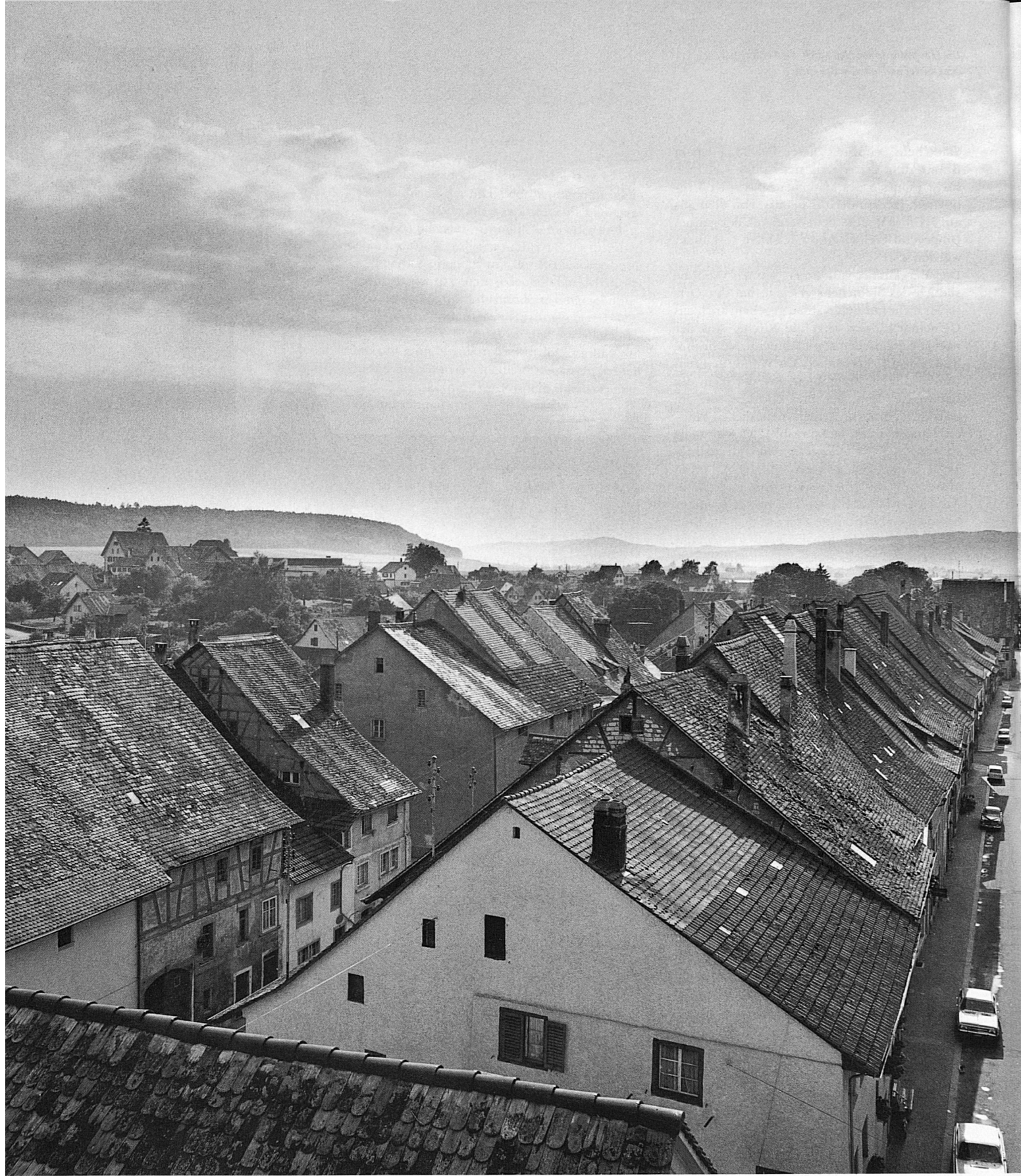
Blick vom 35 m hohen Obertorturm über die Dächer von Neunkirch gegen den Wilchinger- und den Hallauerberg
