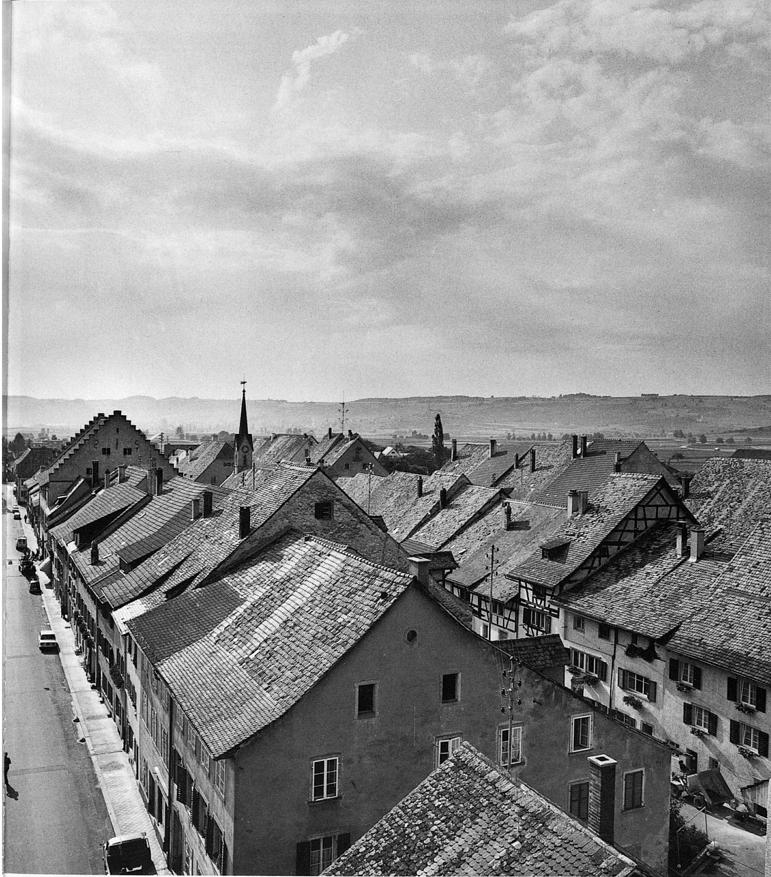
Sguardo dalla torre superiore, a 35 m d'altezza, sui tetti di Neunkirch, in direzione del Wilchingerberg e dell'Hallauerberg
