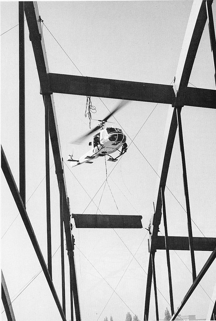
Oben: Kunsteisbahn-Halle in Bern. Montage der Holzkonstruktion mit Helikopter. Photo W. Studer. Unten: Hallenschwimmbad Gstaad. Verleimtes Brett-schichtholz widersteht den Einflüssen des Klimas einer Schwimmhalle. Photo Fäh. Rechte Seite: Ohne Holz geht es selbst beim Bau einer Spannbetonbrücke nicht! Montage des Lehrgerüsts der Monbijoubrücke in Bern. Photo W. Studer
