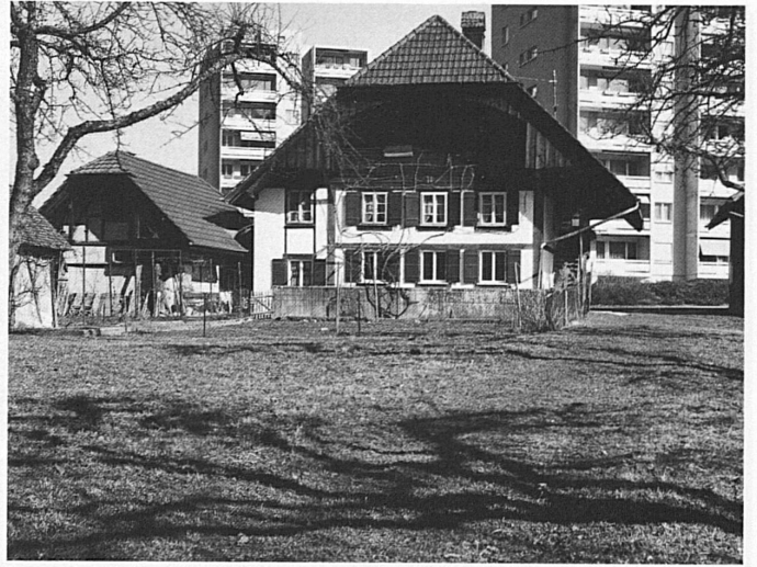
Bereits sind in Bremgarten schlimme Fehlritte geschehen: Moderne Blöcke in Tuchfühlung mit alten Berner Höfen
