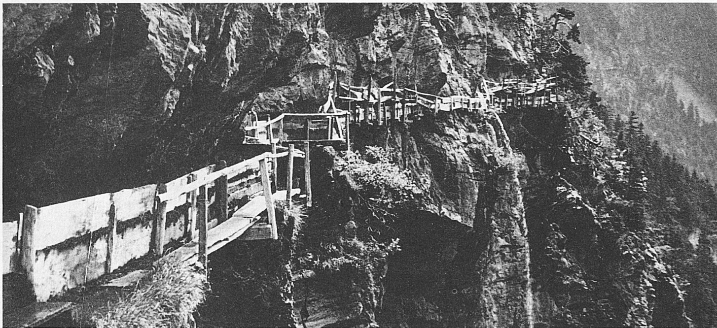
Ein historisches Bild. Solche für Erbauer und Wärter gleich lebensgefährliche, an Felsen aufgehängte Wasserleiten sind heute durch Stollen ersetzt
