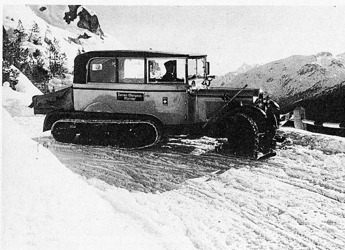
Links: PTT-Alpenwagen mit Hinterradraupenantrieb (Citroën-Kegress) und Vorderradschneekufen für Winterbetrieb am Ofenpass 1934/35.
