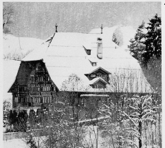
Le Grand Chalet à Rossinière est un des plus grands bâtiments en bois de Suisse. Édifié de 1752 à 1756, il comprend deux façades d'apparat richement décorées et compte au total 113 fenêtres, réparties sur cinq étages au sud et sur quatre au nord. Il a servi d'hôtel pendant une certaine période, mais est maintenant propriété privée
