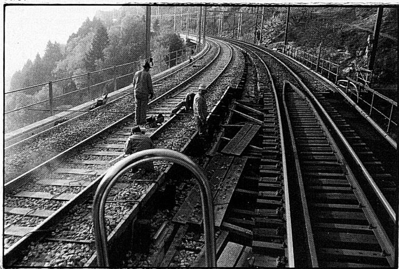
61 *Die talseitige Verbreiterung zur Aufnahme des zweiten Gleises bedingte an den Abhängen der Nord- und Südrampe den Bau von Hängebrücken*
