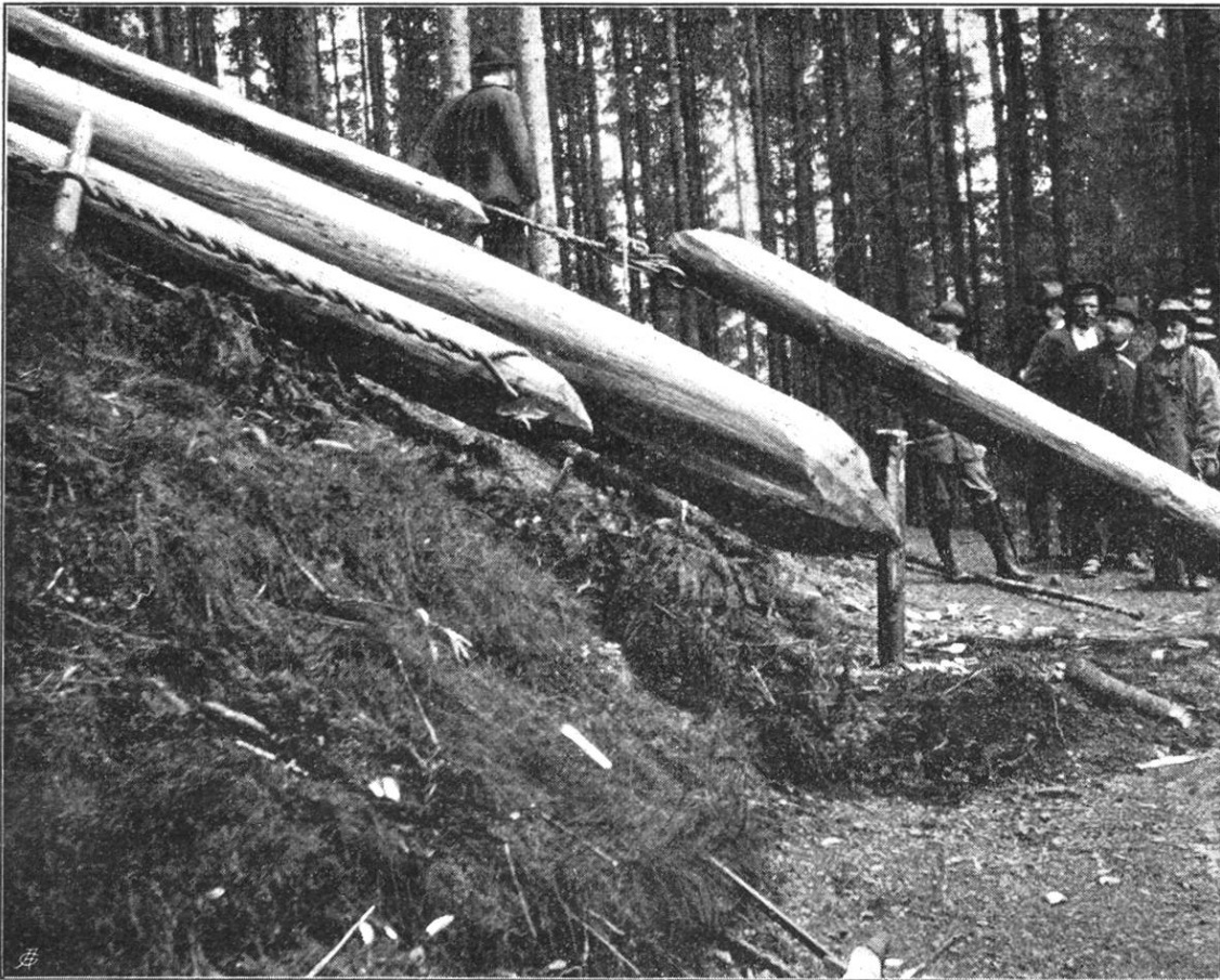
Construction d'une riese.
