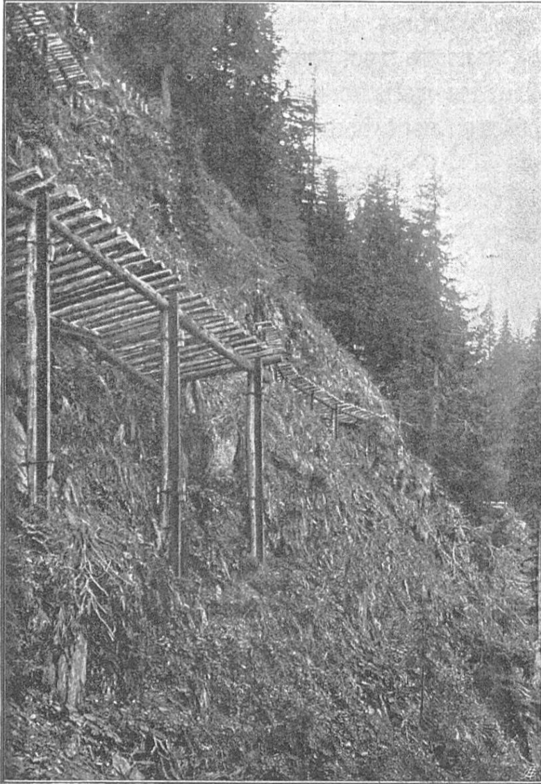
Fig. 8. Ponts à neige établis dans le couloir de l'avalanche de la Calcestri.
