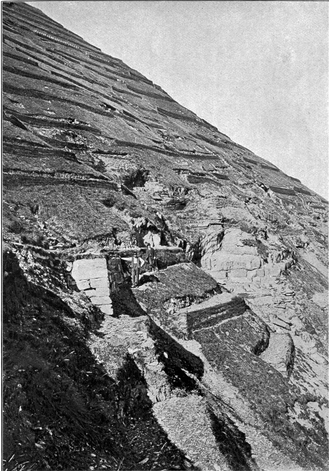
TRAVAUX DE DÉFENSE CONTRE L'AVALANCHE A LA MEISSENPLANKE, PRÈS D'ELM (CANTON DE GLARIS).
