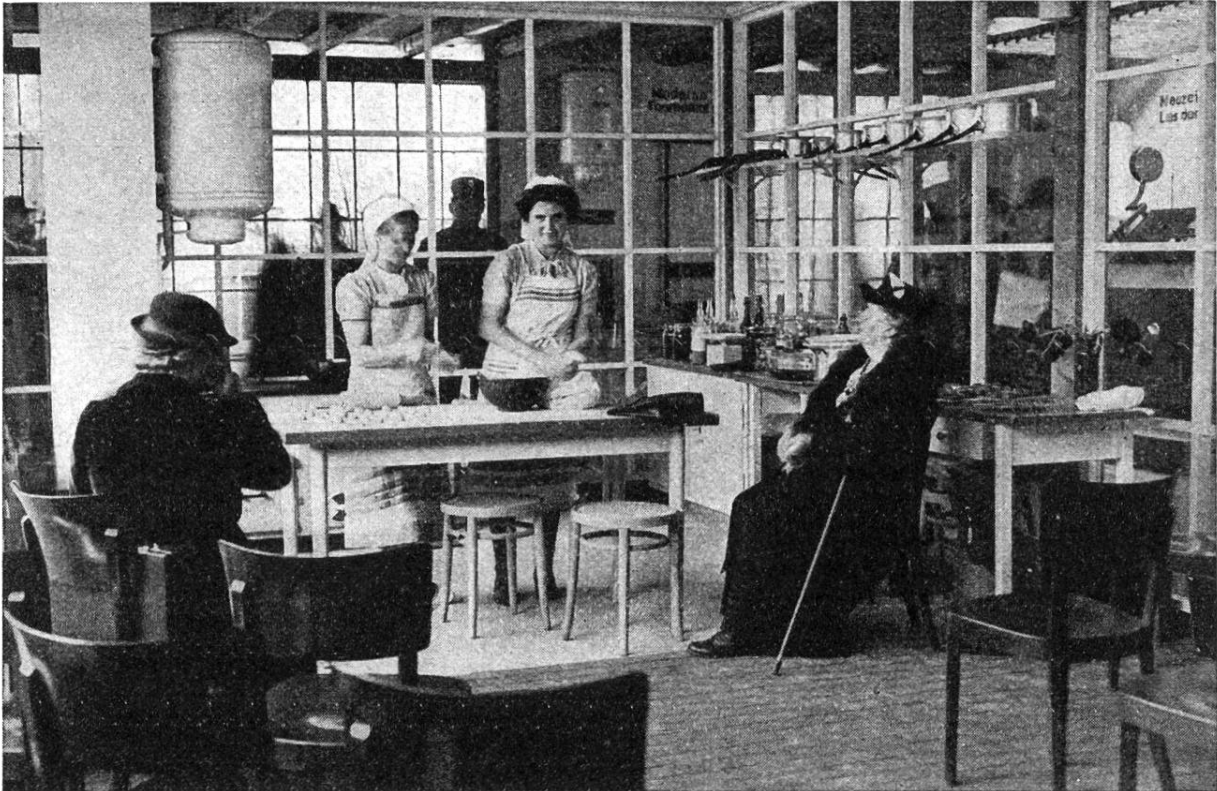
Modèle de cuisine avec potager moderne au bois et boiler.
