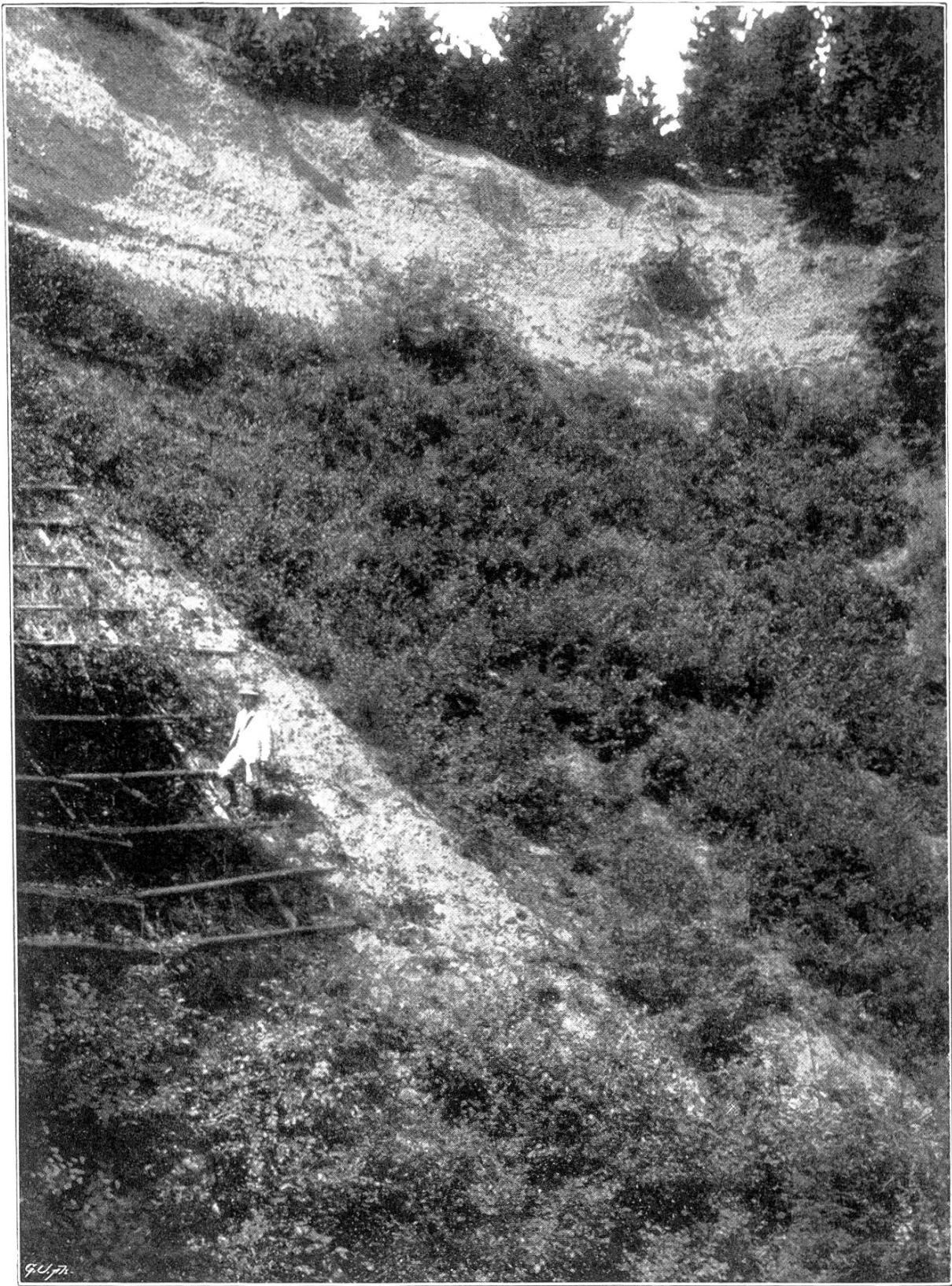
Verbau einer Schutthalde an der Blasensfluh (Emmenthal).
