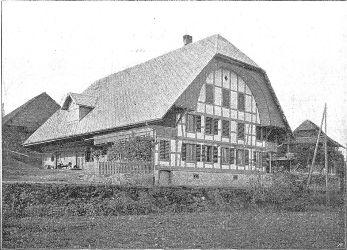
Fig. 2. Mit Sternit gedecktes Haus in Zimmerwald bei Bern.
