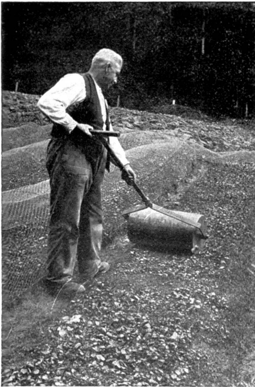
Abb. 2, links: Einwalzen ausgewinteter Alpenerlen (Gewicht der Walze ohne Wasserfüllung 50 kg, mit Wasserfüllung 100 kg).
