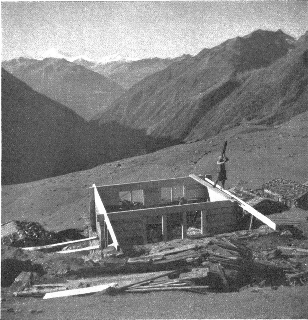
Das neue Haus wächst aus dem Boden.
