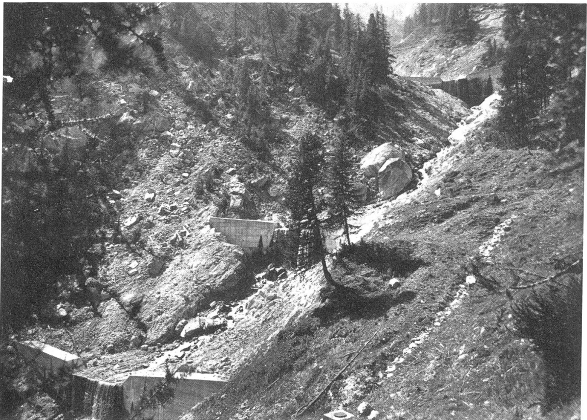
Abbildung 7. Bachverbauung im Münstertal. Aufnahme: R. Jecklin
