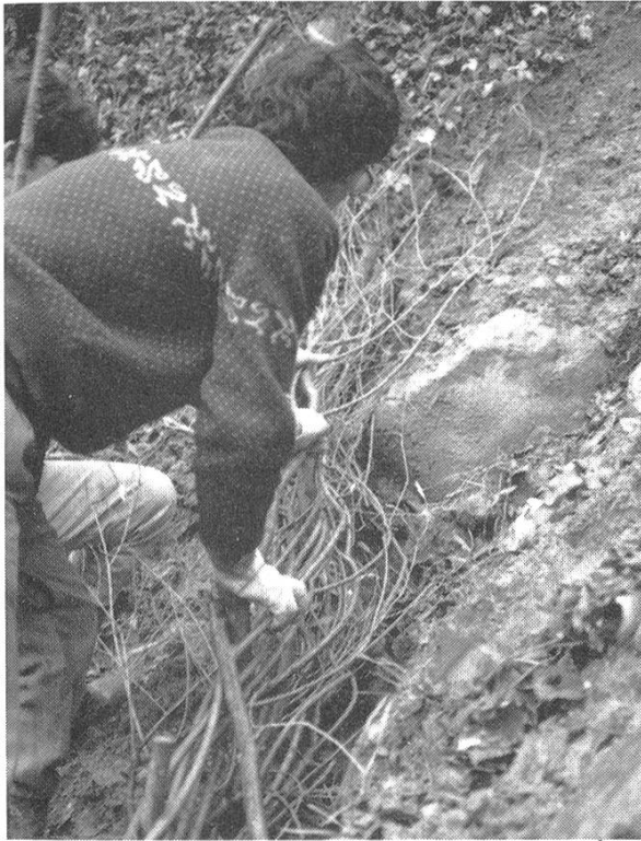
Abbildung 2. Flechtzaun: Im schaufeltiefen Graben werden Weidenpfähle in einem Abstand von etwa 1,00 m eingerammt. Dazwischen werden Weidenäste geflochten und anschließend mit dem Aushubmaterial wieder eingedeckt. So sind die Äste gegen Austrocknung geschützt und können sich zu kompletten Pflanzen regenerieren.
