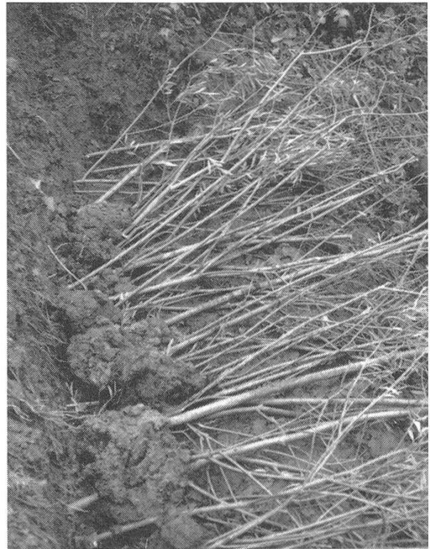
Abbildung 3. Buschlage: Auf einer Berme von rund 50 cm Breite, die gegen den Hang geneigt ist, werden Weidenäste kreuzweise verlegt. Mit dem Aushub für die nächste Lage wird die unten liegende wieder eingedeckt. Abschließend sind die vorstehenden Triebe auf etwa 15 cm zurückzuschneiden.
