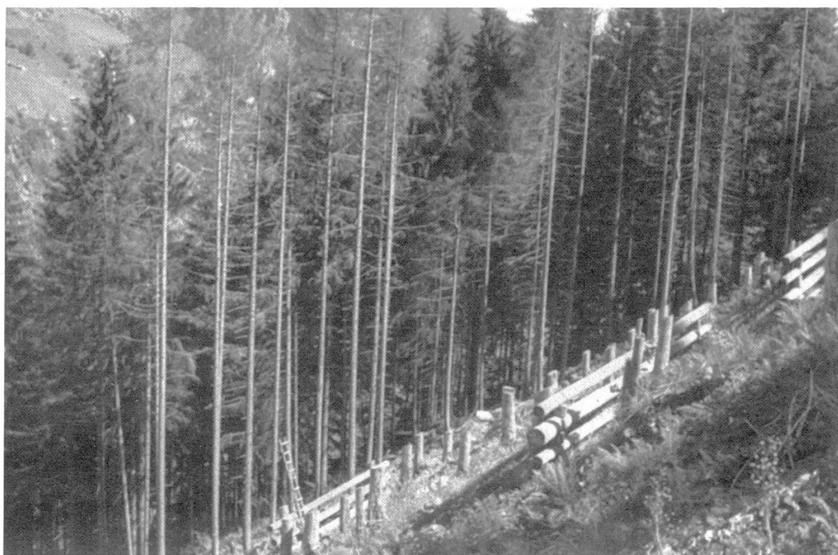
Abbildung 2. Borkenkäferflächen im Baumgartiwald behelfsmässig verbaut.
