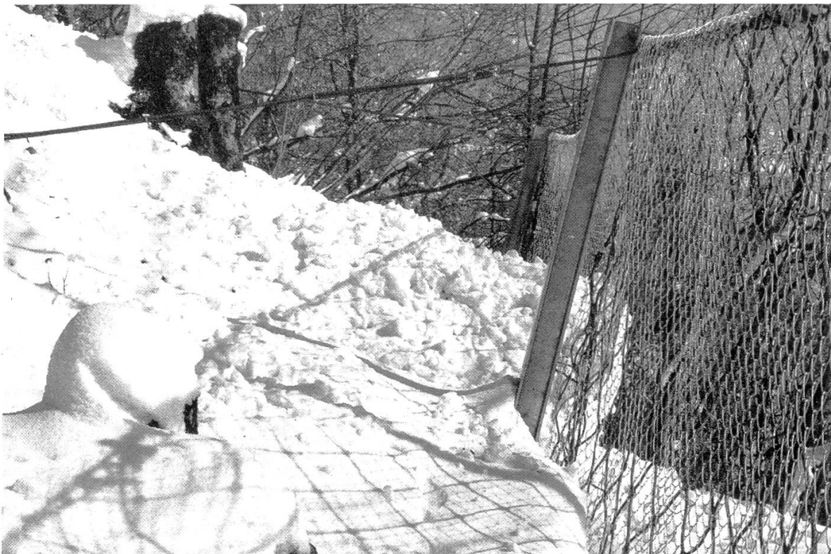
Abbildung 3: Abgefangene Lawine in einem Schneenetz.
