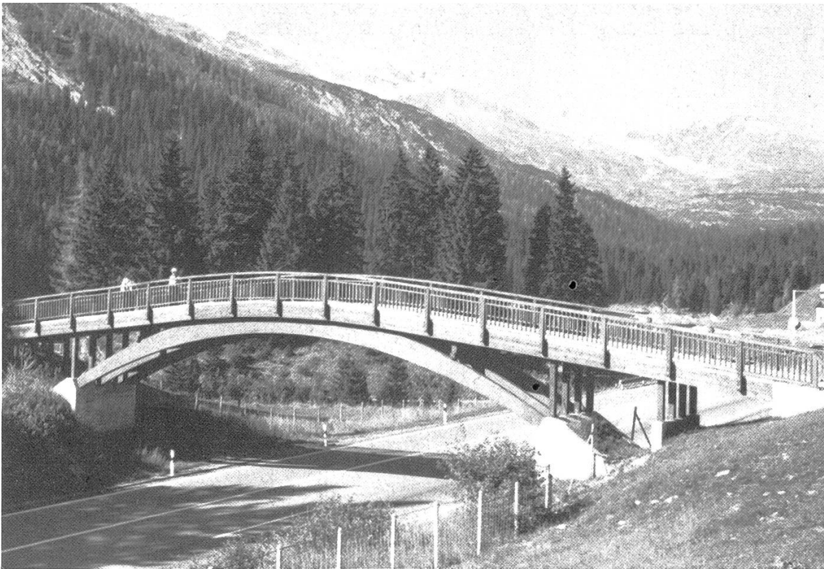
Abbildung 6. Von der Abteilung Holz mitbetreute Holzbrücke über die N13 bei San Bernardino mit Bogenträgern aus imprägniertem Weisstannen-Brettschichtholz.
