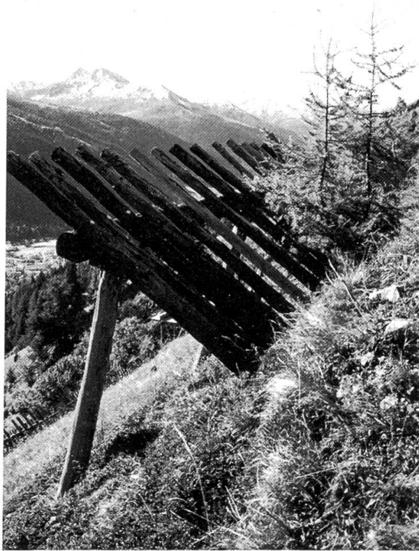
Abbildung 4. Lawinerverbauung im Aufwuchsgebiet.
