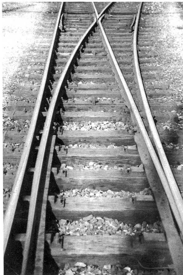
Abbildung 3. Holzschwellen im Eisenbahnoberbau.
