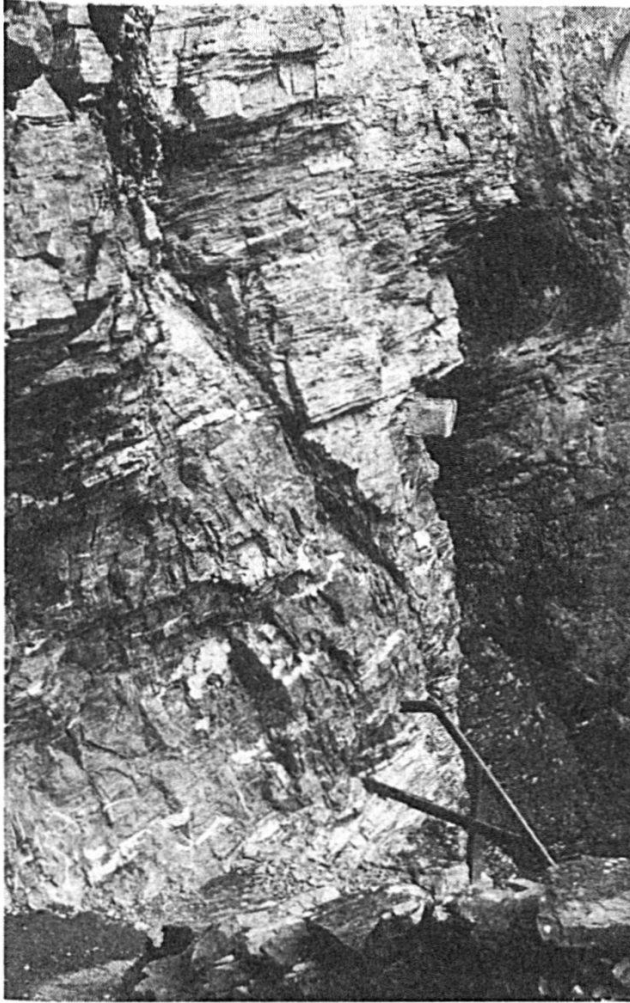
Abb. 23. Gemmi-Südseite. Jahrzahl beim «Chlöfe» (Tafel 3, Ziffer 22). Eingesprengter Weg aus der Zeit von 1739–1741. Wegoberfläche verläuft auf dem Anstehenden, teilweise mit Feinschutt bedeckt. Talseits wurde der Fels mauerartig stehengelassen und dient mit einer aufgesetzten Trockenmauer als Wegabschrankung. Oben im Bild ist links der Mitte ein ca. 25 cm hohes, schräg nach links fallendes Felsband zu erkennen, das Spuren einer eingemeisselten Jahrzahl trägt (siehe Abb. 24). An der Felskante rechts oberhalb der Bildmitte ist der «Chlöfe», ein eingesetztes Balkenstück, sichtbar. – Standort: LK 1267 – 613 175/138 070 / ca. 1970 m; Bildmitte Az ca. 300 A‰. (Aus AERNI 1971, Abb. 30.)
