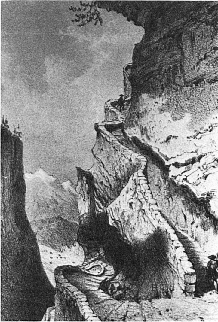
Abb. 20. «Chemin de la Gemmi près de Louèche les Bains». Der Zeichner stand beim «Chlöfe» (Tafel 3, Ziffer 22). Sehr deutlich sind die künstliche Einsprengung des Weges und die zum Schutz der Passierenden angebrachten Seitenmauern dargestellt. Es scheint, dass die heute üblichen Holzzäune damals nicht bekannt waren. – Zeichnung von Loppe, Lithographie von Tirpenne, Druck Lemercier in Paris. Die Zeichnung ist undatiert und stammt aus der Zeit um 1860 (Standortnachweis: Schweiz. Landesbibliothek, Graphikmappen klein, Kt. Wallis F–K, Umschlag «Daubensee und Schwarenbach»).
