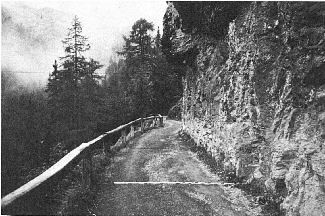
Abb. 14. Gemmi-Nordseite (Stock – Spittelmatte): Fahrweg von 1874 (b = 2,3 m). Weg ausgesprengt (runde Bohrlöcher mit 31 mm Durchmesser). Wegoberfläche bekiest, gelegentlich mit flachen Steinplatten begrenzt. Vergleichsstab 2 m lang. In 50 cm Höhe über dessen rechtem Ende ist die Jahrzahl 1874 eingemeißelt. – Standort: LK 1267 – 616 275 / 145 025 / 1830 m. Weg achse Az 3600 A‰. (Aus AERNI 1971, Abb. 7.)
