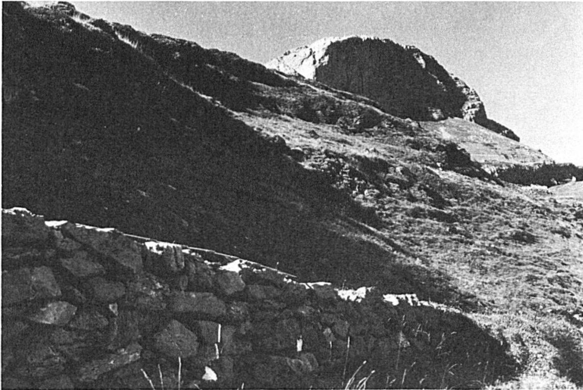
Abb. 12. Gemmi: Schwarzenbach – Daubensee (Tafel 2, Ziffer 20, Situationsaufnahme zu Abb. 13). Gebauter Weg von 1852/53. Das weisse Dreieck am untern Bildrand links der Mitte entspricht der in Abb. 13 eingetragenen Messmarke. (Aus AERNI 1971, Abb. 27a.)
