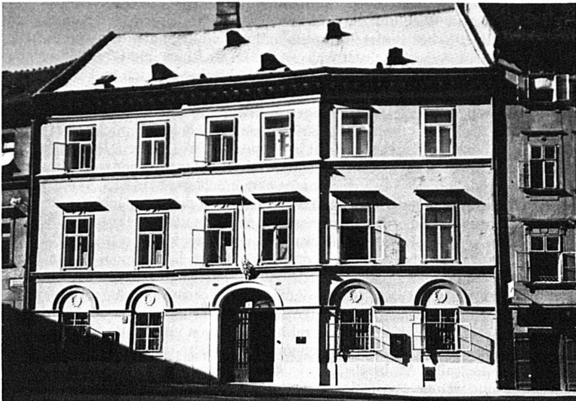
Schweizerisches Generalkonsulat Bratislava, Franziskanerplatz 5 (1942–1945). Das Gebäude gehörte einer gebürtigen Schweizerin aus Bern.
