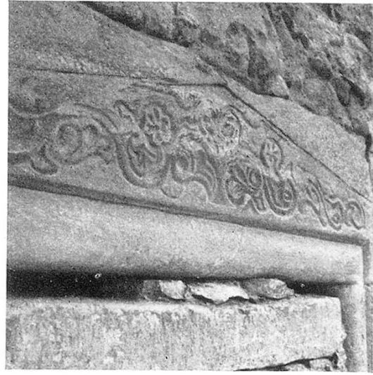
Architravartiger Sturz der romanischen Türe in der Nordfassade
