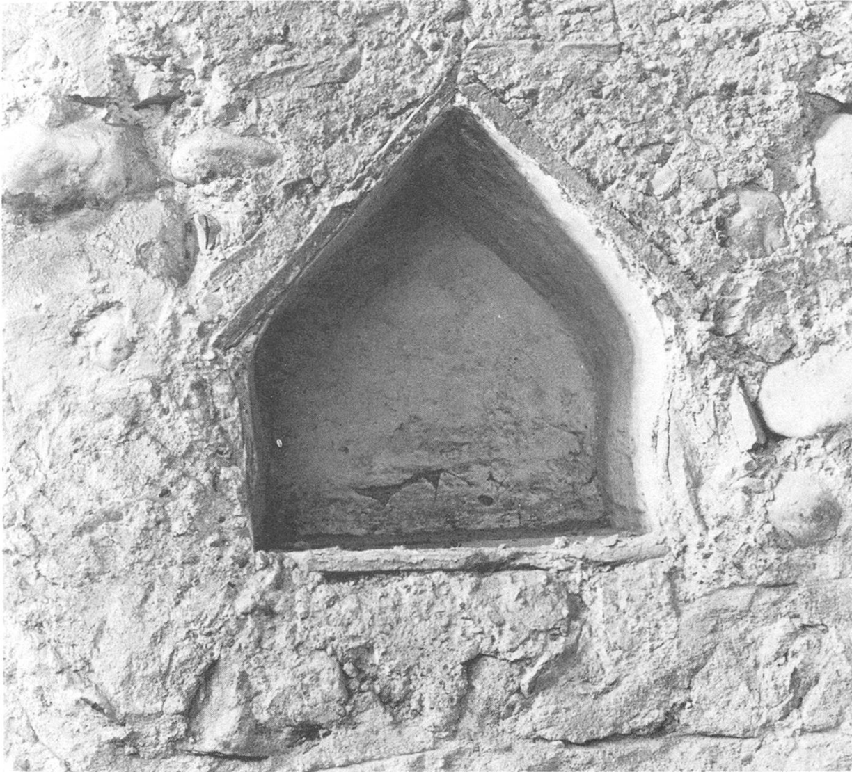
Abb. 3. Diessenhofen, Haus Untere Mauer 10 (Südfront der Stadtmauer, neben Thüerenturm), Giebelnische in mittelalterlicher Seitenwand, Tiefe zirka 32 cm, d.h.: ein Fuss Diessenhofer Mass. Die Wand datiert, den Fugenstrichen und Maueranschlüssen nach zu urteilen, aus dem 12. oder 13. Jahrhundert. Die Giebelnische ist an den Rändern verflickt und deshalb nicht genau datierbar. Sie diente wahrscheinlich der Kontrolle der Mauerdicke diesseits der Hofstättengrenze.
