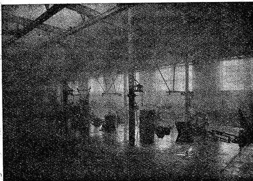
Luftverhältnisse im Raum vor Inbetriebsetzung der Anlage. Feuchte Wände und mangelhafte Betriebsübersicht.
