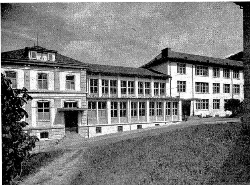
Webschule Wattwil Links: Verwaltungsgebäude; Mittelbau: Zeichnungssaal, im Parterre, darüber der große Hörsaal. Rechts: Haupteingang und Unterrichtsräume.
