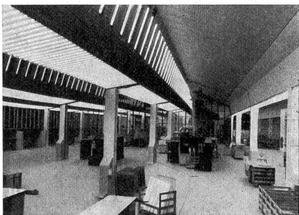
Fig. 7 Teilansicht einer Shed-Fabrikationshalle mit Blick auf die Fensterflächen. Die Beleuchtungsstärke beträgt über 1000 Lux
