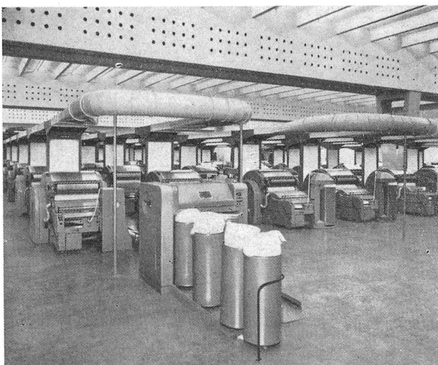
Abb. 5 «Aerofeed»-Kardenspeisung; rechts mit Kannenablage links mit Railhead bis Regulierstrecke (Rieter)
