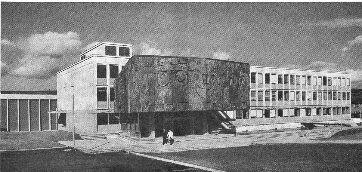
Technisches Zentrum des IWS in Ilkley
