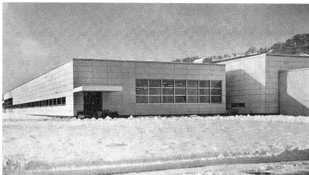
In diesem neuen Anbau ist die Appretur der Seidengazefabrik Thal untergebracht. Oben einer der Ansaugstutzen der Klimaanlage
