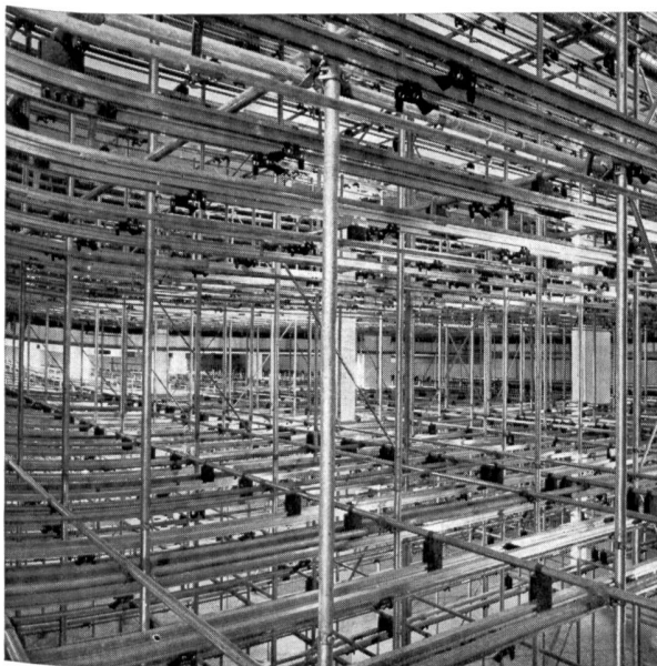
Blick auf 4etages Hängewarenlager während der Montage
