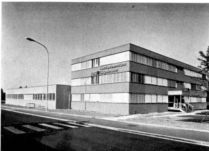
RZG Neubau, Murgenthalstrasse 12, Langenthal
