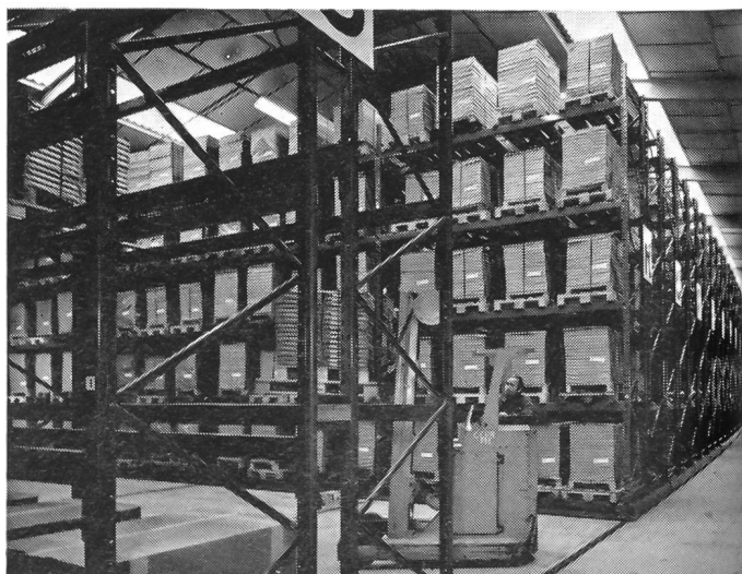
Diese Anlage steht bei der Firma Müller-Brunner AG in Rheinfelden. Sie ist das beste Beispiel dafür, wie Sie durch direktes Anschliessen der platzsparenden Gleitregalanlage an die Fabrikation Arbeitswege und dadurch Personal einsparen können. — Werkfoto Foco Forster AG, Aesch.
