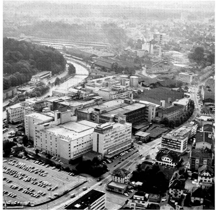
Hauptsitz der Viscosuisse AG, Emmenbrücke
