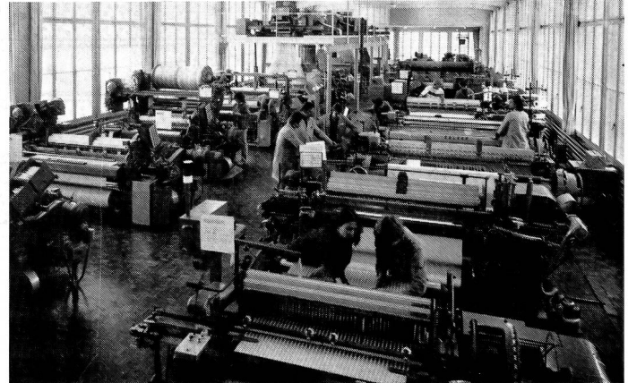
Maschinensaal der Weberei in Wattwil
