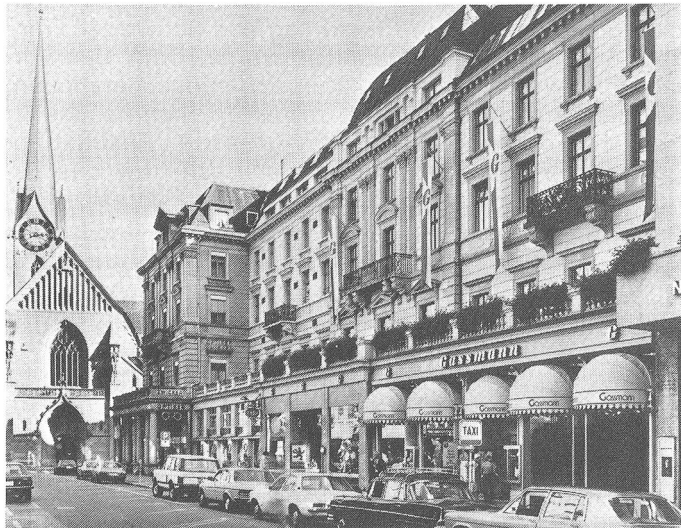
Das Geschäftshaus der OTTO JACQUES GASSMANN AG an der Poststrasse 5 und 7 beim Paradeplatz, (im ehemaligen Postgebäude)
