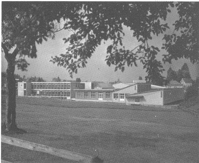
Der Produktionsgebäude-Trakt wurde in den 60er Jahren errichtet.
