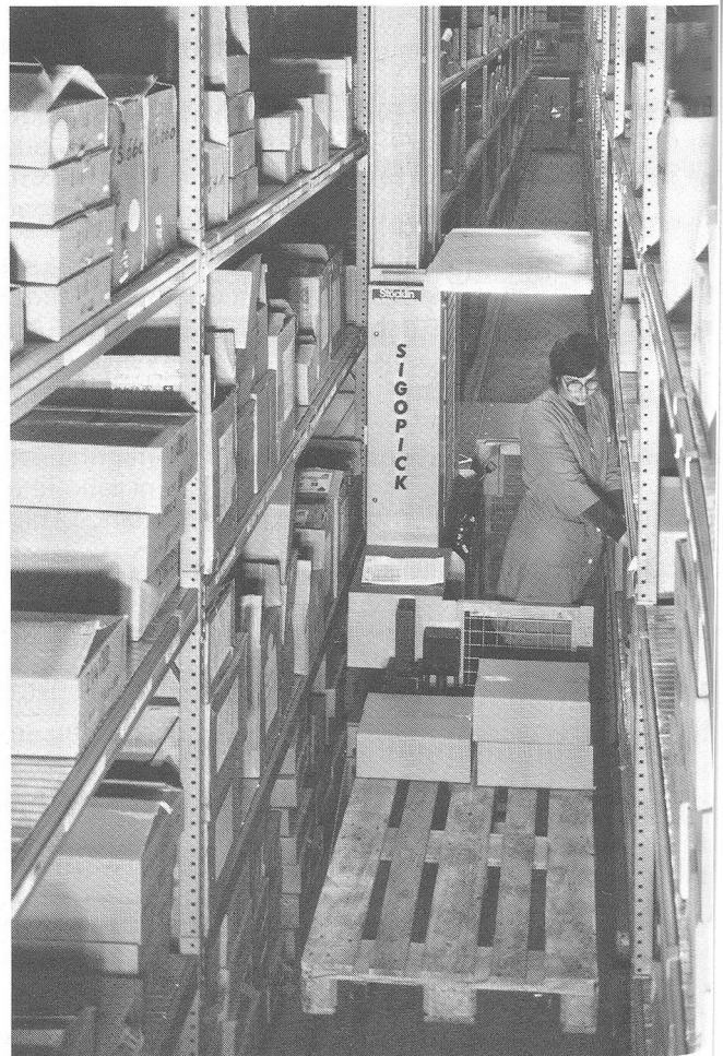
SIGOPICK-Kommissioniergerät im Einsatz im Textillager eines Grossverteilers. Die Bedienungsperson kommissioniert aus den Tablarregalen direkt auf die Palette. Letztere wird durch höhenverstellbare Gabeln getragen. Die günstige Arbeitshöhe kann gewählt werden.
