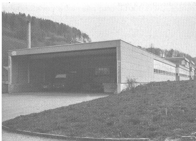
Der Neubau mit Zufahrtsrampe im Vordergrund
