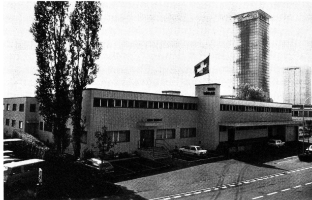
Frontansicht des 1983 erweiterten Hauptgebäudes
