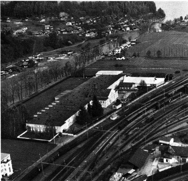
Das Betriebsgebäude hinter dem Ostbahnhof Interlaken
