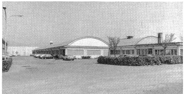
Produktionshallen und Bürotrakt (rechts im Bild) der Tessitura di Stabio. Der Erweiterungsbau erfolgt direkt anschliessend an das bestehende Gebäude
